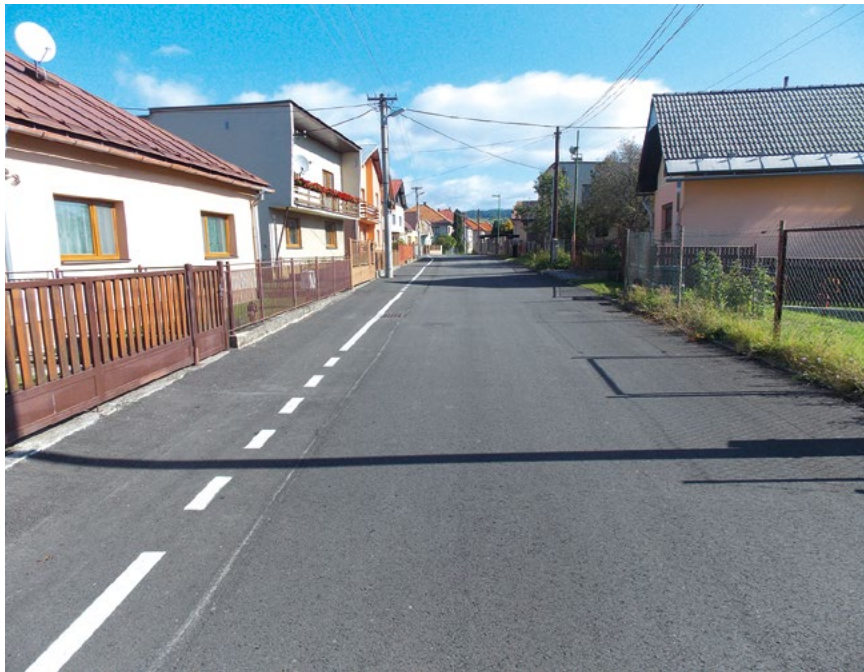
Ulica Záhumnie s novým asfaltom
