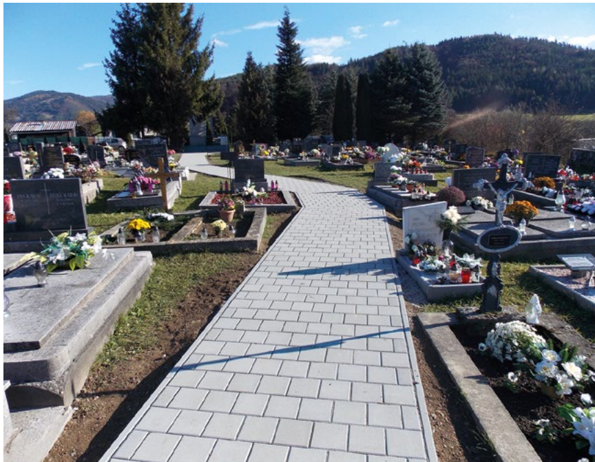
Novovybudované chodníky pre návštevníkov cintorína
