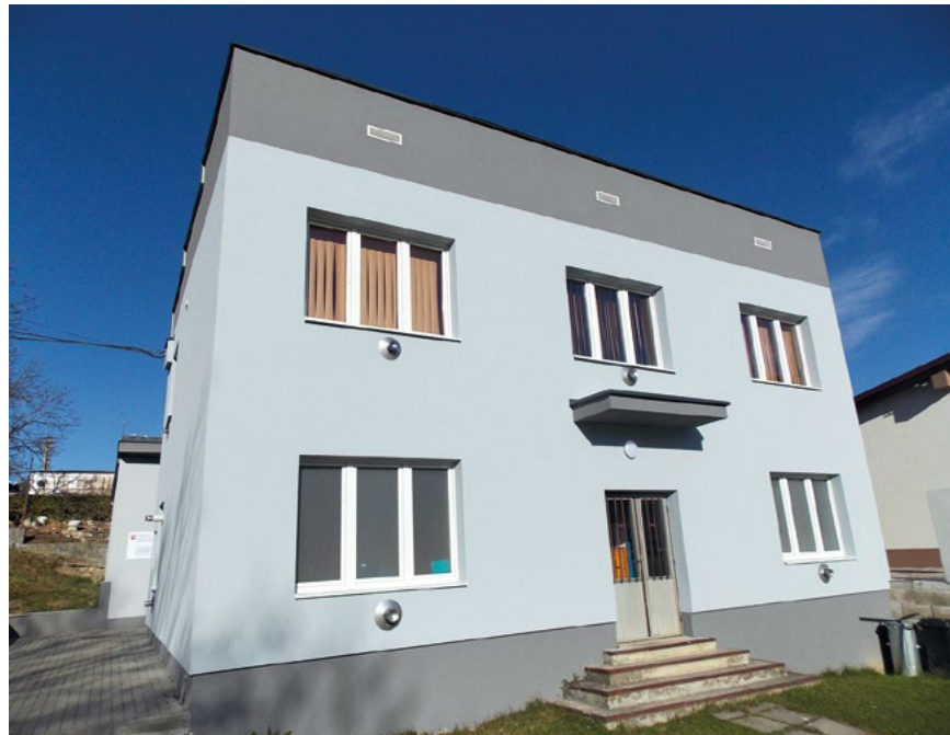
Pôvodné kabíny TJ Sokol s novou fasádou
