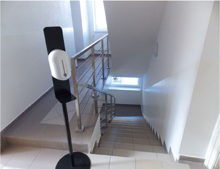
Zrekonštruované priestory chodby na obecnom úrade
